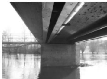
**Die Rohre der Wasserversorgung sind unter der Brücke aufgehängt**
